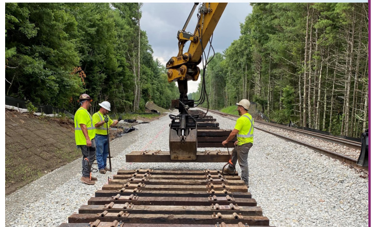
Colocación de lazos en el derecho de paso
