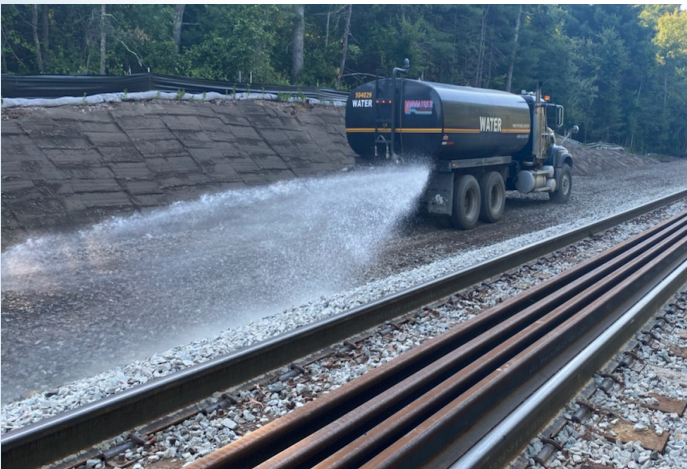
Control del polvo en el derecho de paso de la calle Cotley
