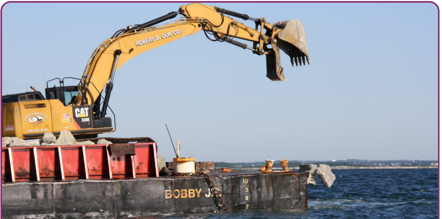
Garra deixando cair algumas peças de granito da SCR em águas locais para construir o recife
